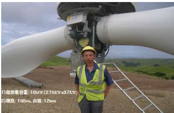
写真3 フィジー電力公社(FEA)での風力発電の建設
