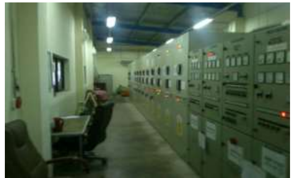
写真 8 既設発電制御室
