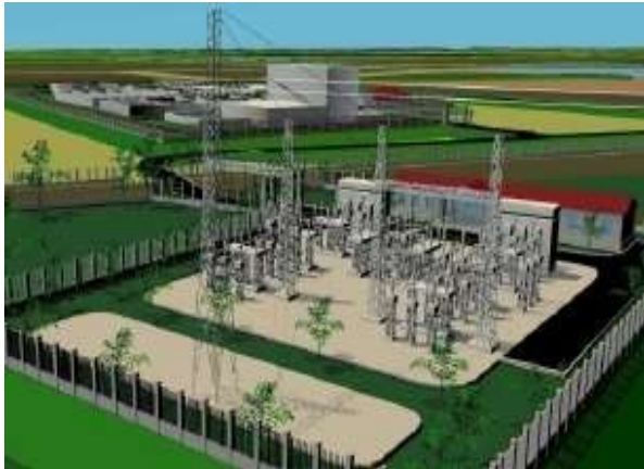
写真 15 230/33kV 屋外変電設備完成予想図
