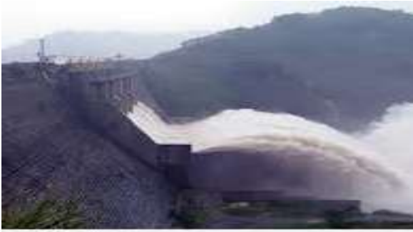
Fig-3.8a 計画貯水水位まで貯留できないための放流（出典：ベトナム研修員によるカントリーレポート）
