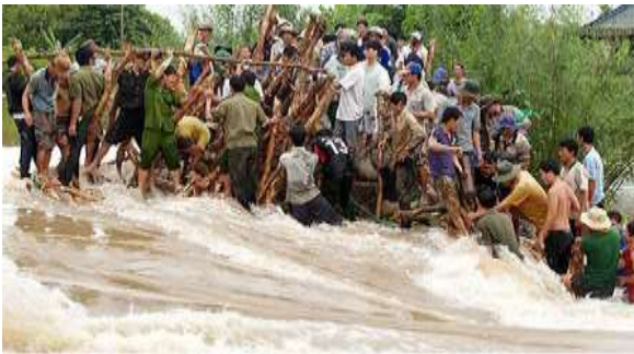
Fig-3.8b 洪水による決壊堤防の補修（出典：ベトナム研修員によるカントリーレポート）
