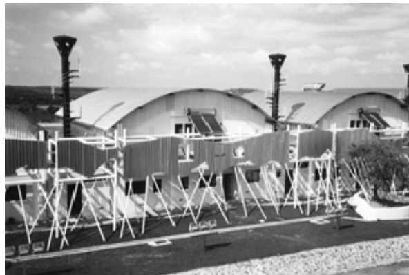
図-4 食品科学研究所の建設状況
