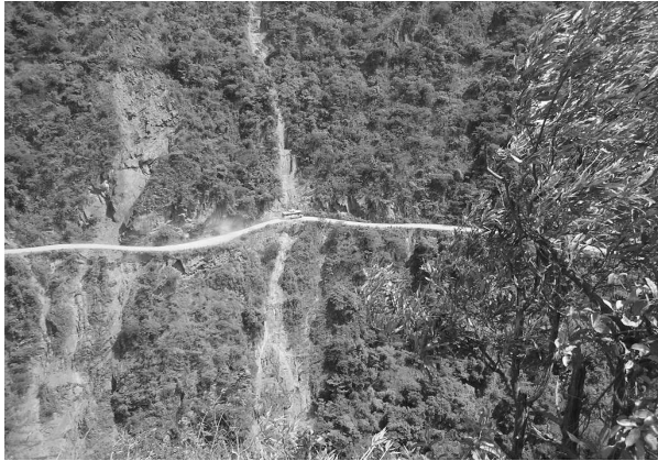
ユンガス道路雨季には滝になる
